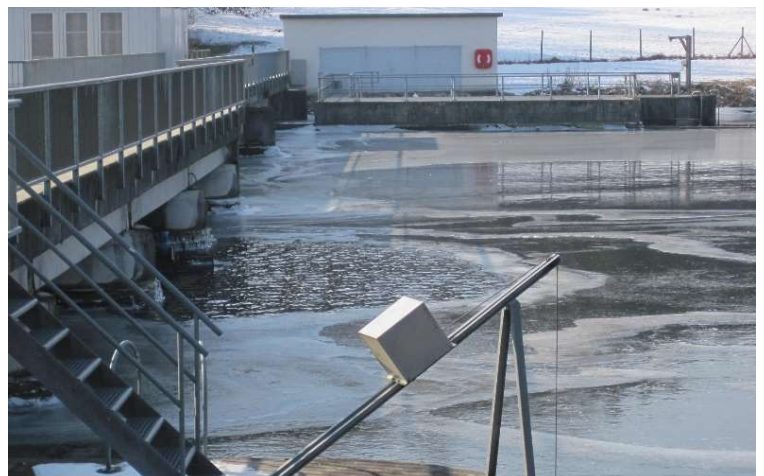
28.02.2018 Alle 4 Wehrklappen im Bild nur mit OLOID eisfrei
