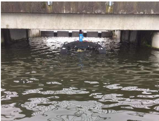
23.1.2018 OLOID Typ 400 mit Strömungsrichtung zur Wehrklappe
